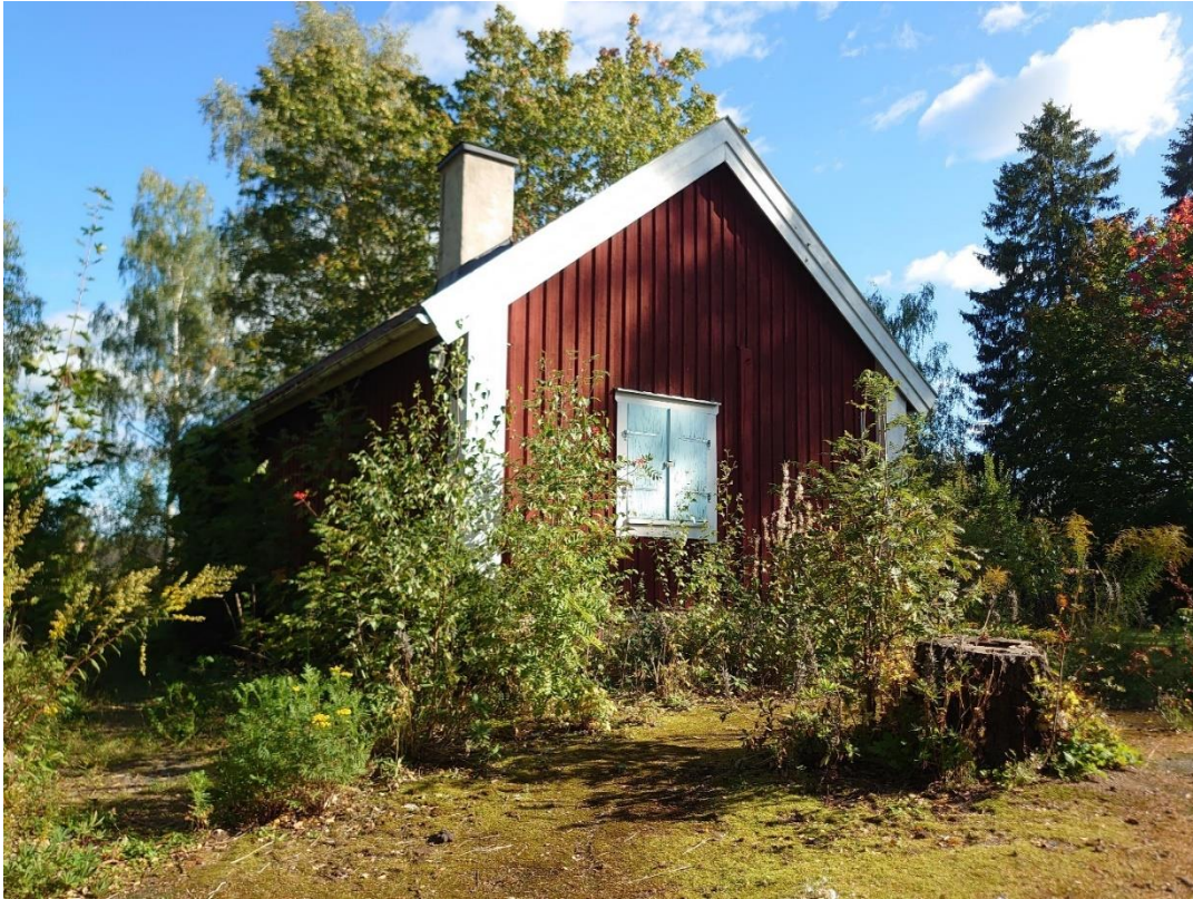
Figur 7. Torpets norra långsida och västra kortsida.
