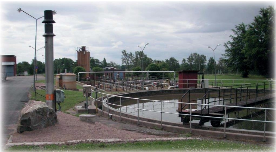
Avloppsreningsverkets bassänger i Hallstahammar.
