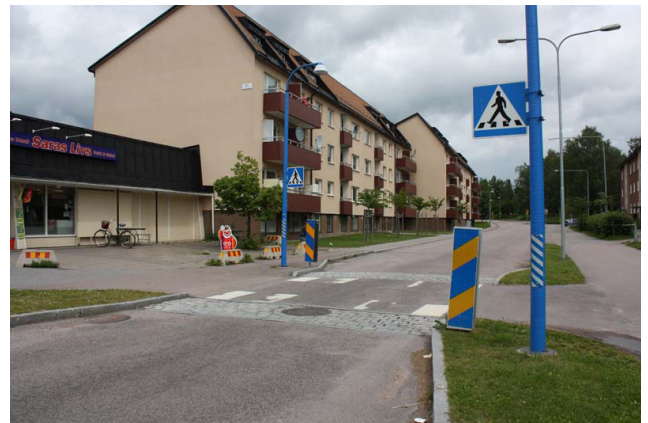
Upphöjt, avsmalnat och väl skyltat övergångsställe på Parkgatan ger förutsättningar för en låg hastighet.
