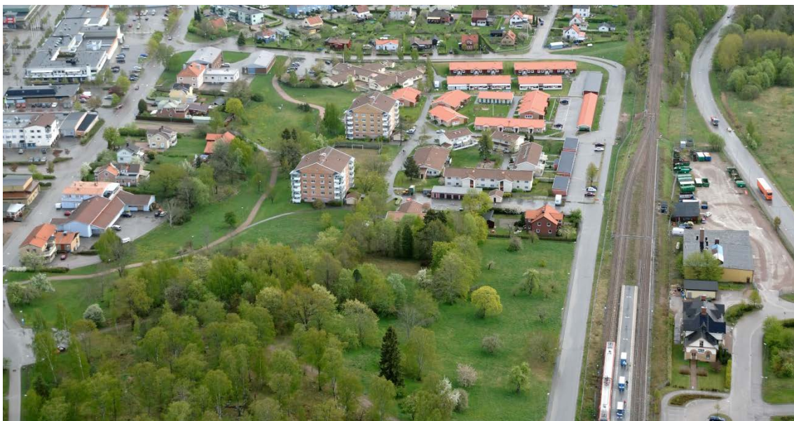
Figur 13 Flygbild från norr som visar delar av planområdet i förgrunden samt angränsande bebyggelse bakom.
